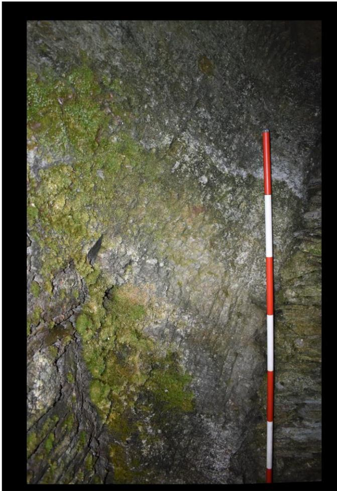
Fig. 8. La parete interna di un bunker sulla quale sono chiaramente visibili i segni di utensili.
